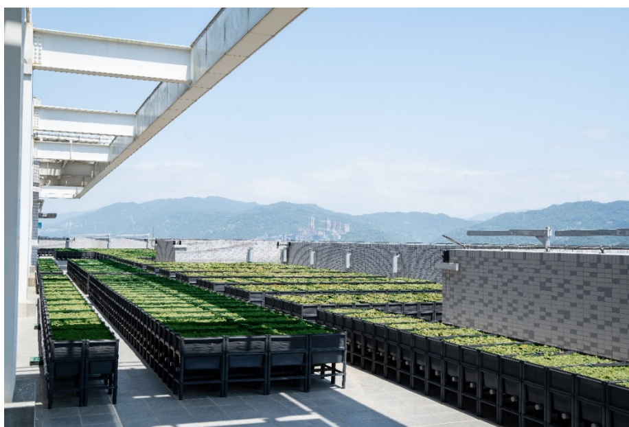
圖三 南港機廠社會住宅 1 區頂樓實景
